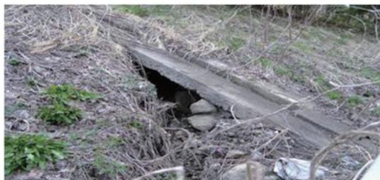
■ 通水阻害により、水が溢れ、のり面が洗堀した例
