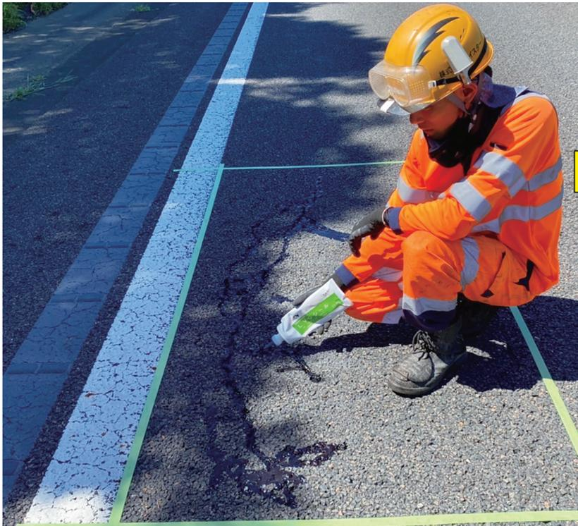
ひび割れの深くまで浸透して既設舗装と強力接着
