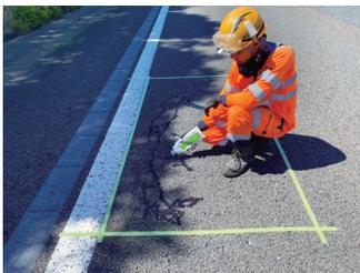
① ひび割れにLVOシールを施工
