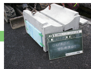
4. 凹部に EPS 取付 (中央分離帯側のみ)
