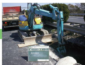
2. 既設撤去・掘削
