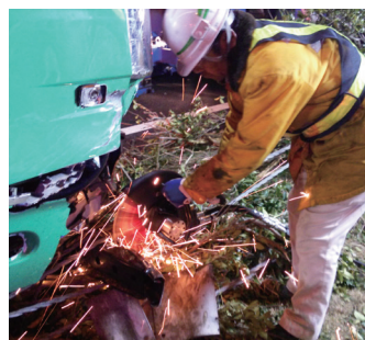
事故復旧作業(エンジンカッター)
