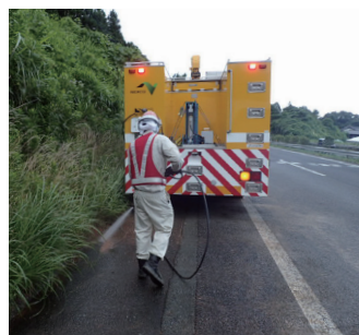
事故清掃作業(高圧洗浄機)
