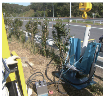
事故復旧作業(支柱引抜機)
