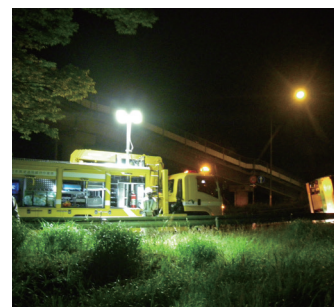
事故復旧作業(車載LED照明装置)
