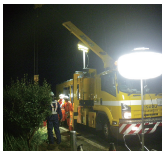
事故復旧作業(LED投光器)
